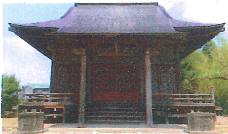
保存修理事業が終了した愛染堂の正面
